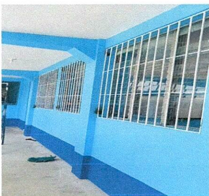
Foto 3: Mantenimiento de repello de paredes (zócalo) Posterior
