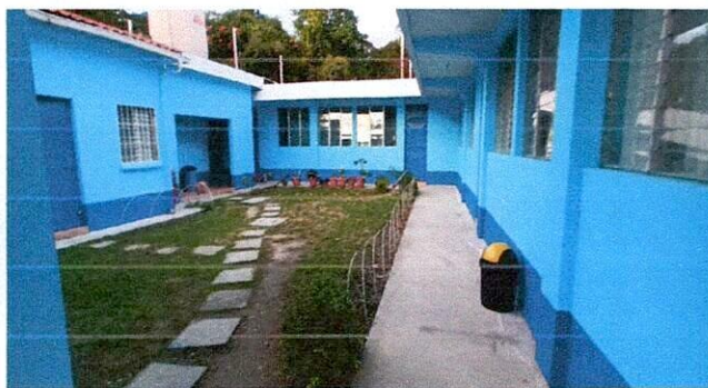
Foto 1: mantenimiento de pintura de la escuela Posterior
