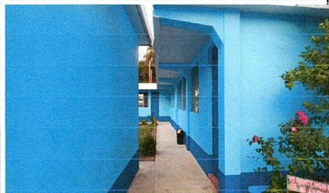
Foto 2: mantenimiento de pintura de la escuela Posterior
