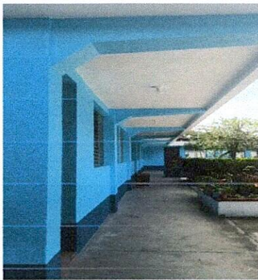
Foto 3: Mantenimiento de instalación eléctrica Posterior
