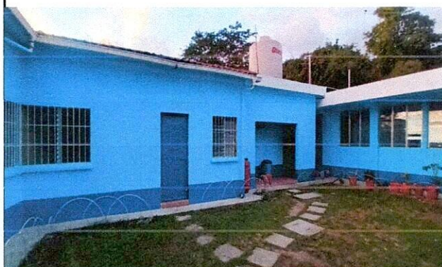
Foto 4: Mantenimiento de repello de paredes (zócalo) Posterior
